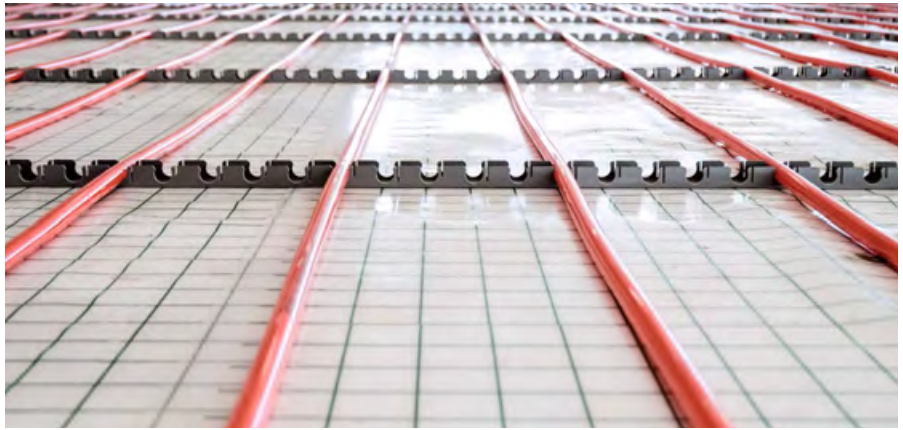
•• Укладка труб водяного напольного отопления
