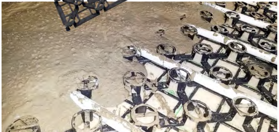
•• Панель Spider (R979S) для укладки труб тёплого пола и заливка всей конструкции бетоном
